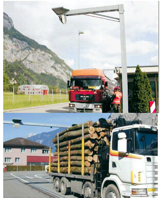
Scanerul laser pentru mediul exterior, ce stă la baza sistemului de măsurare a profilului camioanelor, detectează dacă dimensiunile vehiculelor sunt conforme cu legislația în vigoare
